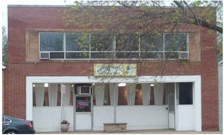
4427-4429 West Fond du Lac Avenue May 1, 1987
