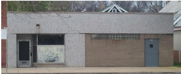
4433-35 West Fond du Lac Avenue April 1, 1992
